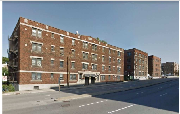
Photo 8 - 1.2 Type multiplex, 4 étages
